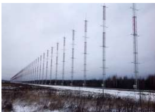
Рис. 8 Приемная часть радиолокационной станции
