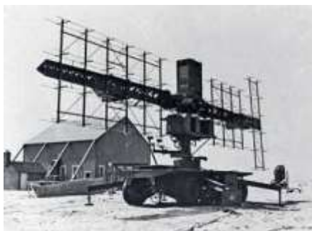
Рис. 7 Установка «Редут», предназначенная для пеленгования самолетов
